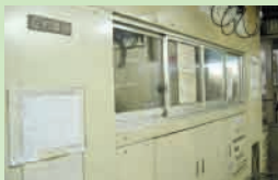
自動4槽式洗浄装置
