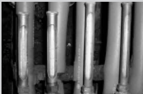
洗浄装置下部でむき出しの計器
