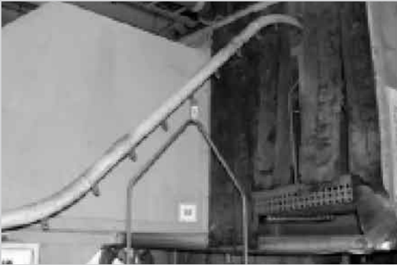
洗浄装置入口の局所排気は上部に設置
