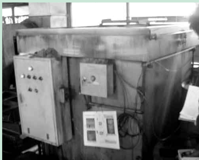
洗浄装置へ作業手順を掲示
