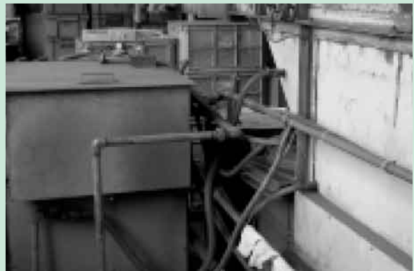
蒸留器の温度、配管を変え、廃液量を改善
