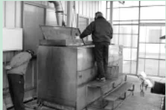
手動3槽式洗浄装置2
